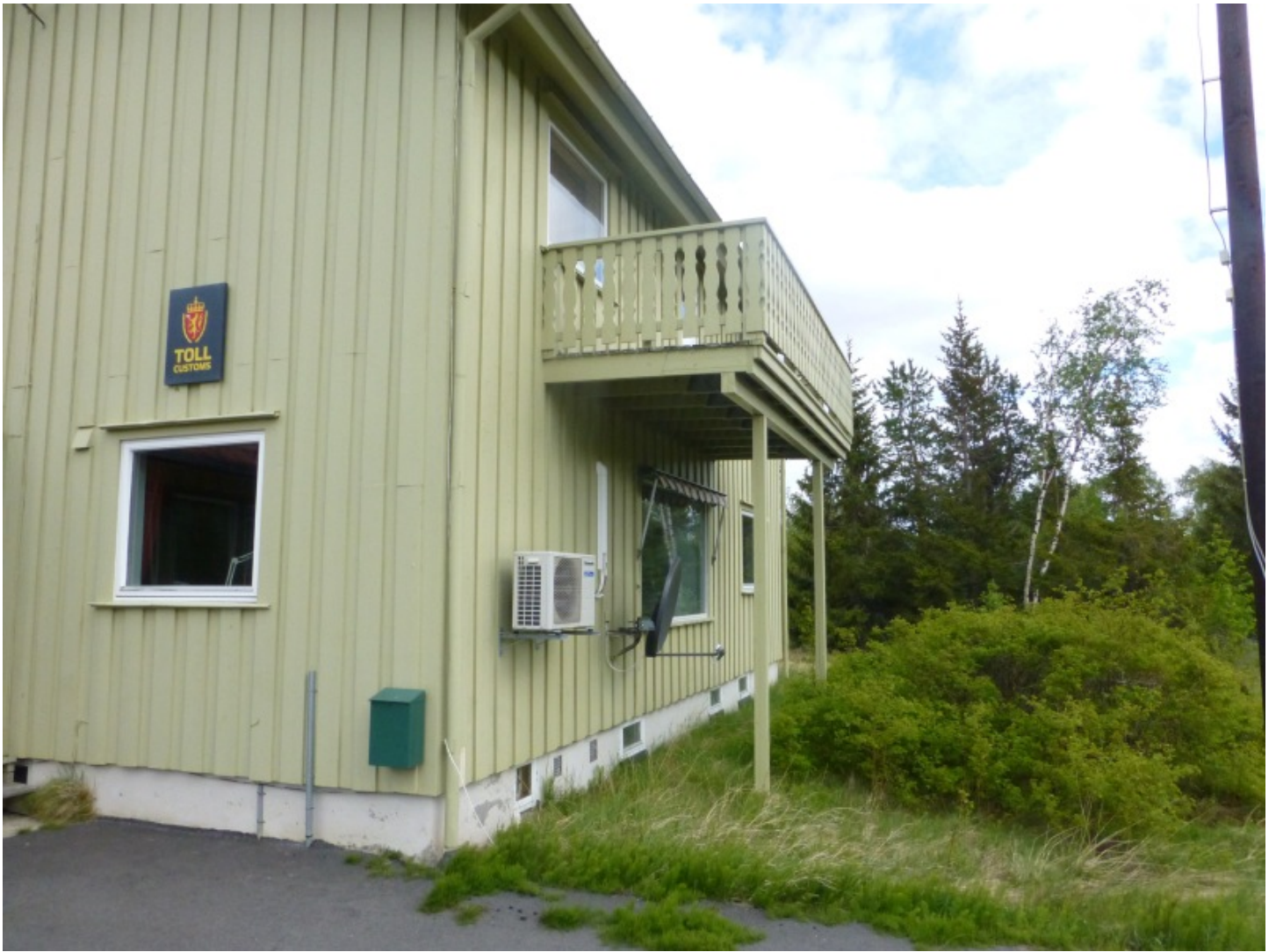
Utsnitt fasade med balkong mot syd. Foto Arkitektskap juni 2016
