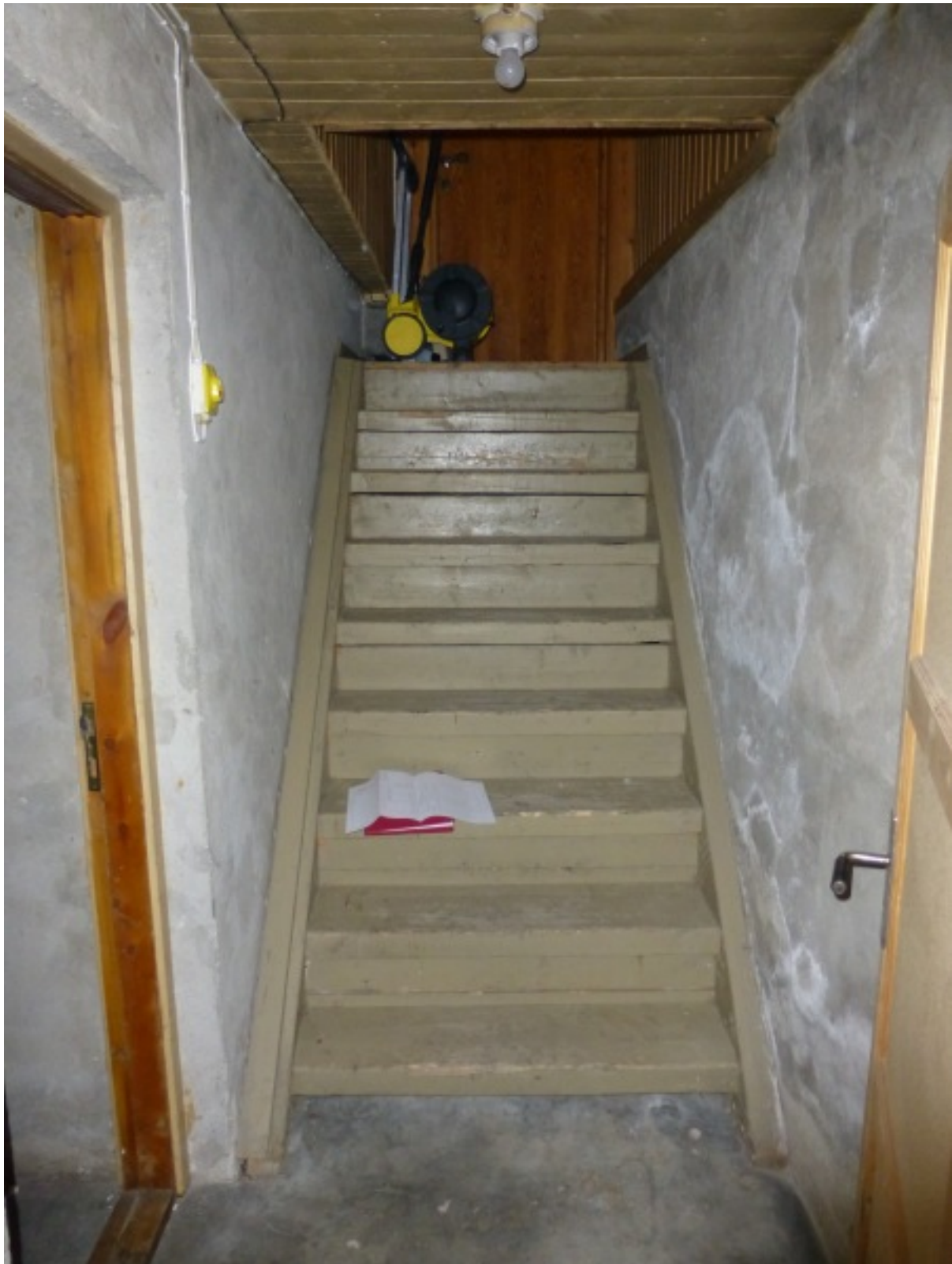
Original trapp til utgangsdør mot nordøst. Foto Arkitektskap juni 2016
