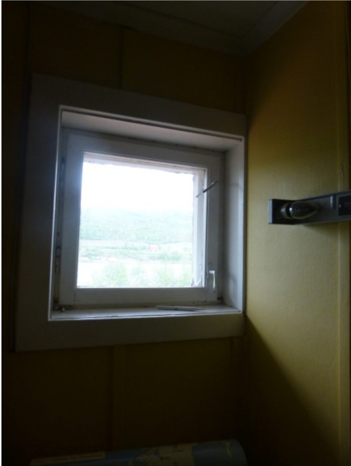
Originalt vindu i andre etasje bad. Foto Arkitektskap juni 2016
