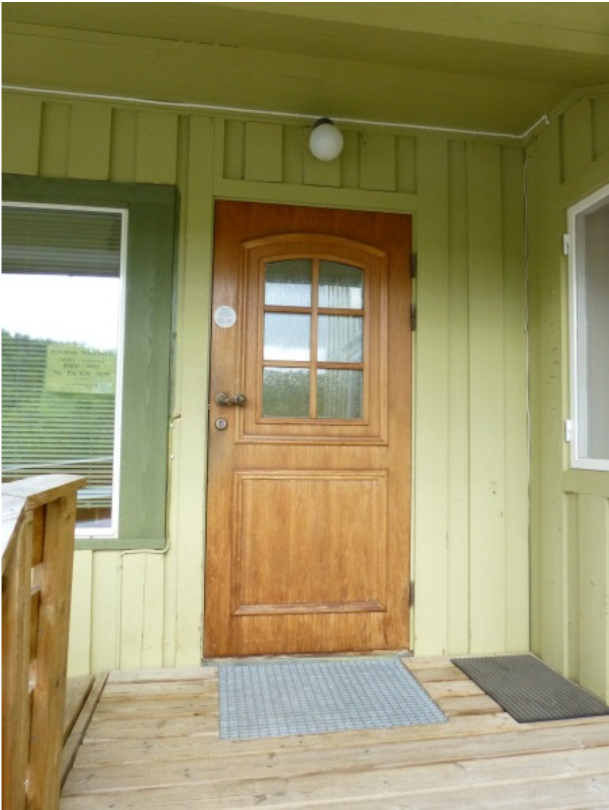
Hovedinngangsdør. Foto Arkitektskap juni 2016
