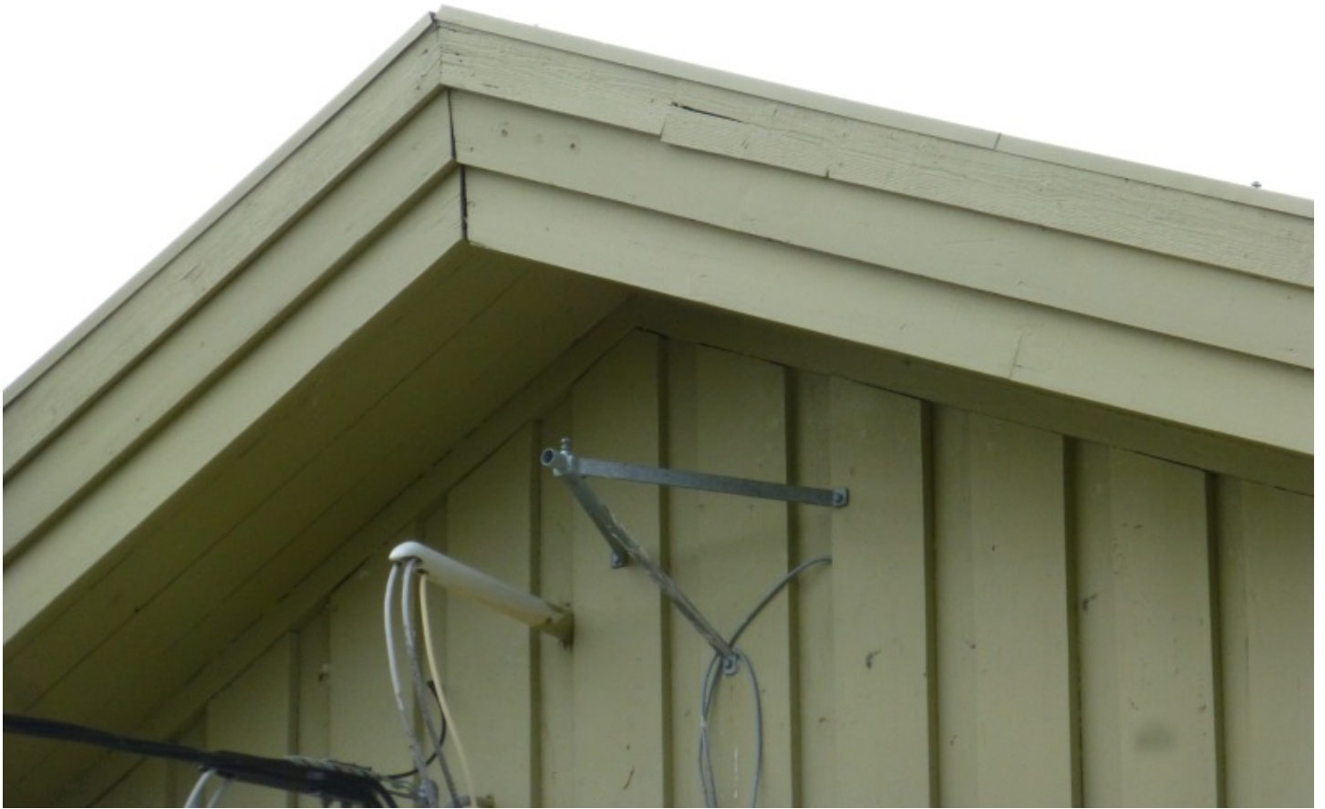
Gesims mot sydøst. Foto Arkitektskap juni 2016
