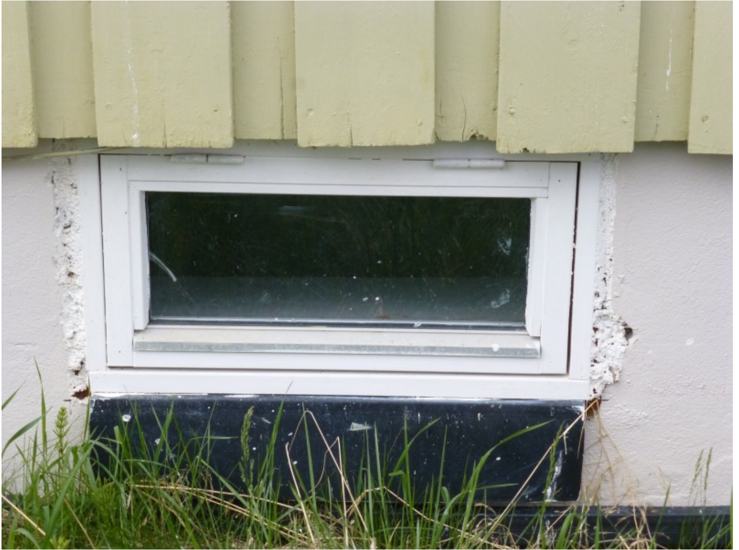
Kjellervindu av nyere dato. Foto Arkitektskap juni 2016
