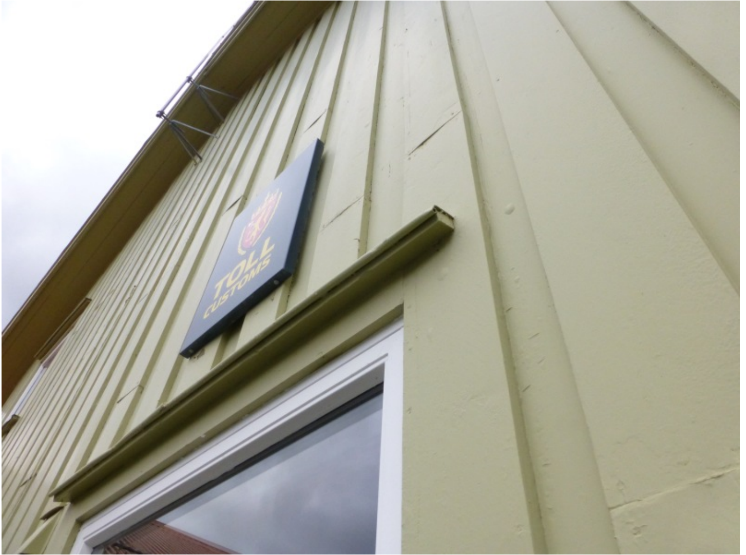
Typisk originalt vannbord over vinduer. Foto Arkitektskap juni 2016
