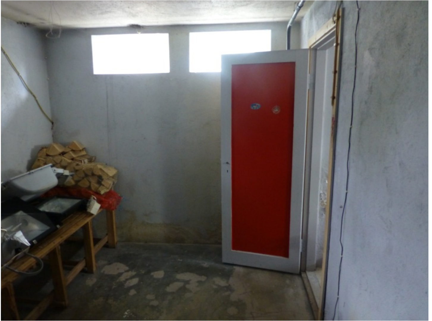
Original dør i kjeller. Foto Arkitektskap juni 2016
