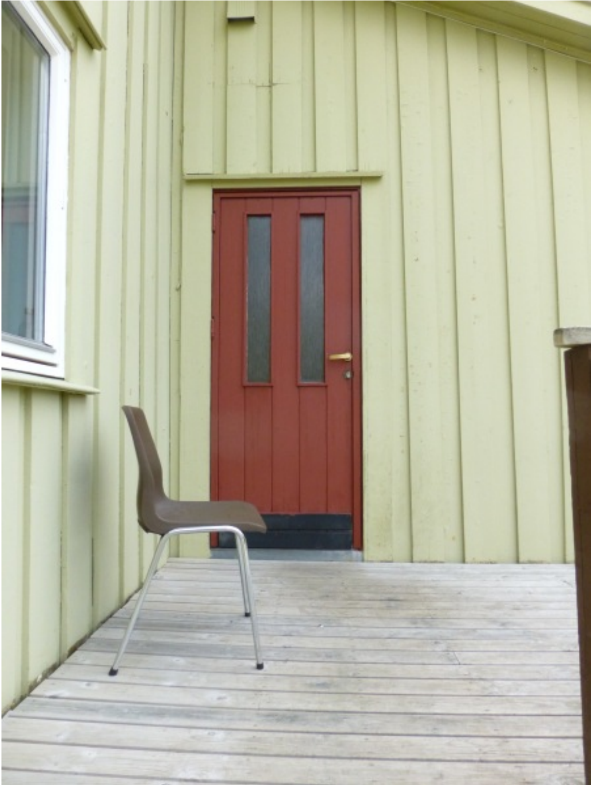
Inngangsdør ved terrasse mot øst. Foto Arkitektskap juni 2016
