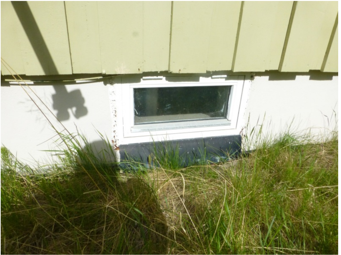
Utsnitt sokkel med vindu. Foto Arkitektskap juni 2016
