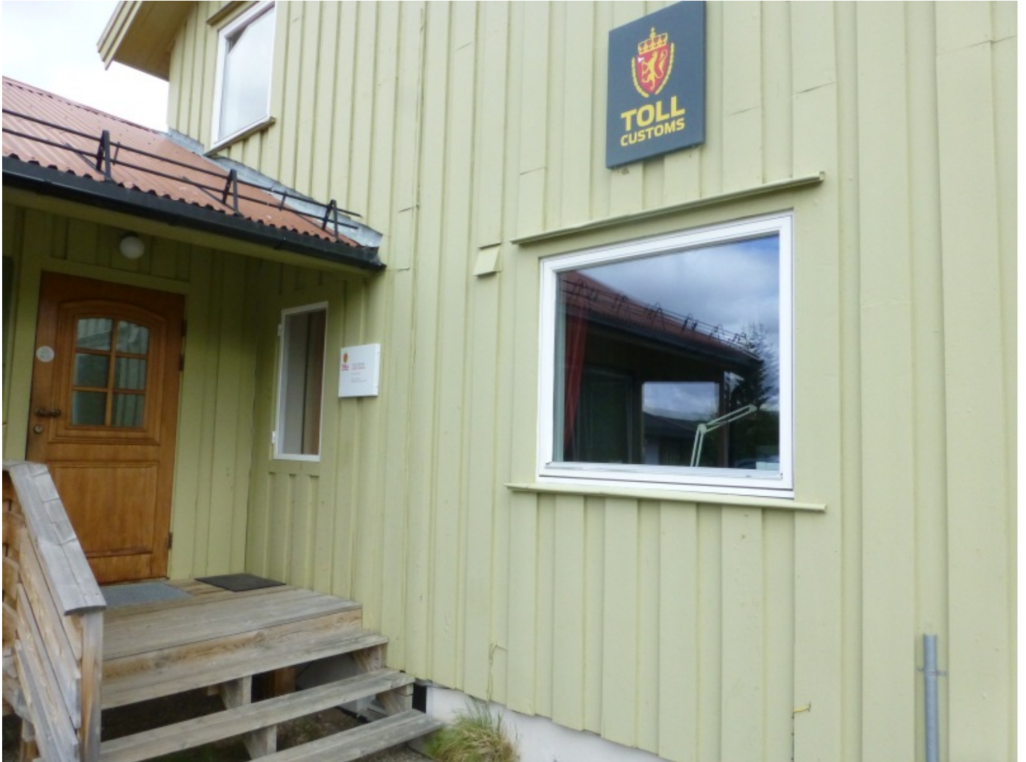
Utsnitt fasade ved hovedinngang. Foto Arkitektskap juni 2016
