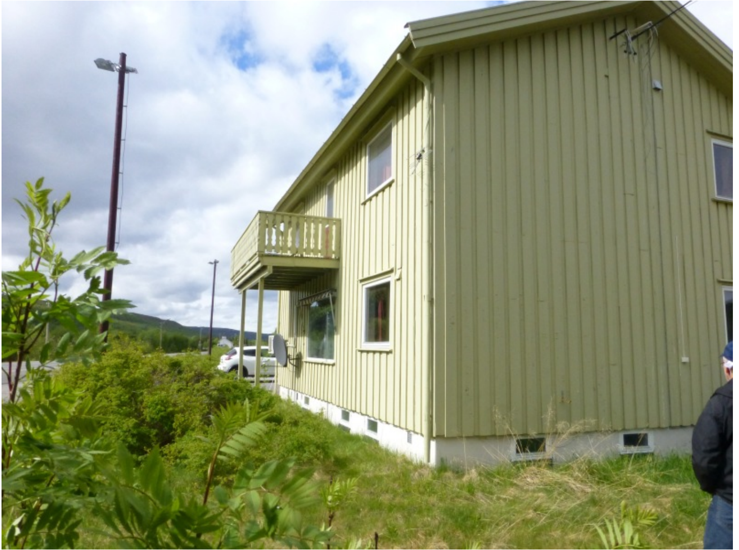
Bygget sett fra sydøst
