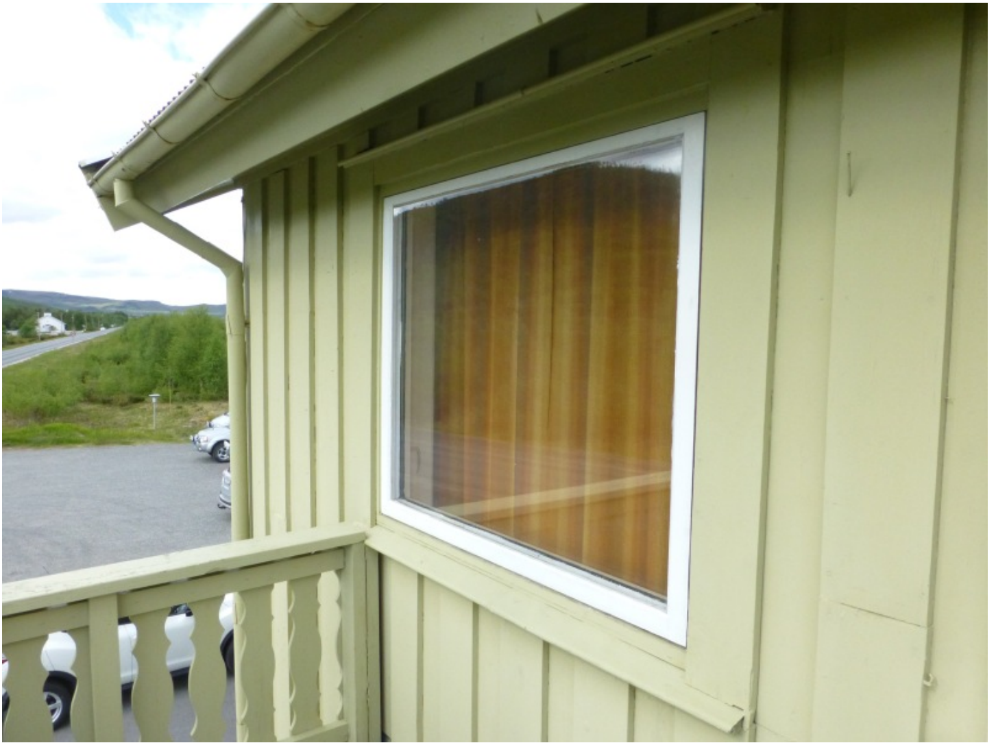
Vindu ved balkong i andre etasje. Foto Arkitektskap juni 2016
