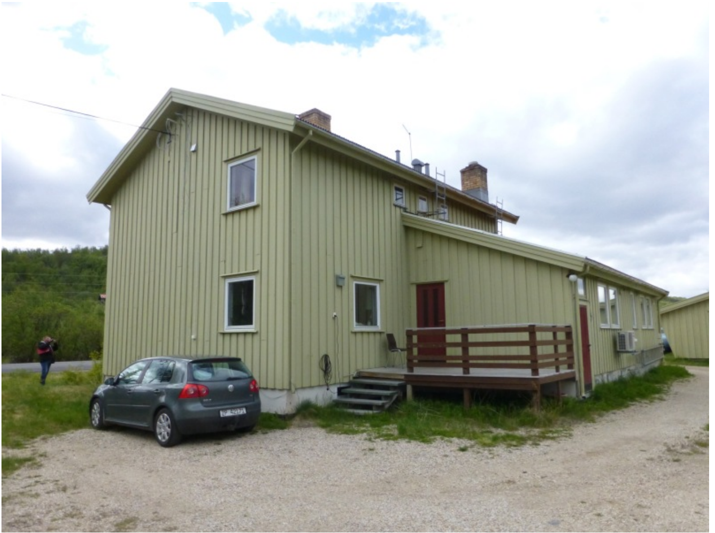
Fasade mot nordøst. Foto Arkitektskap juni 2016
