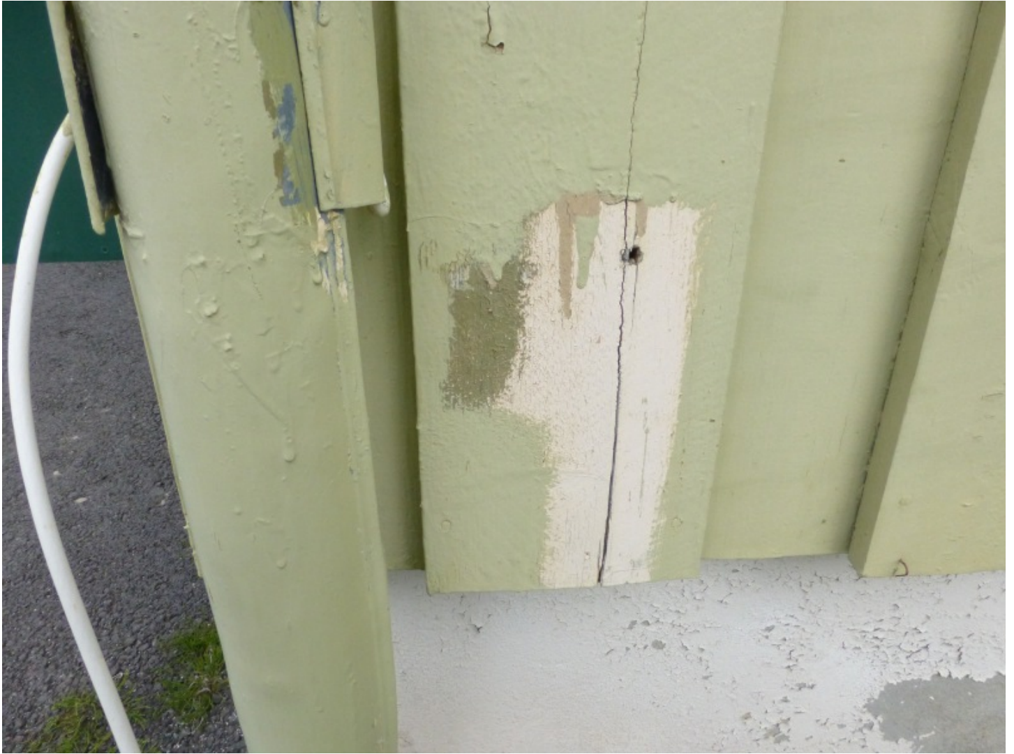
Utsnitt av hjørne mot sydvest som viser eldre fargelag. Foto Arkitektskap juni 2016
