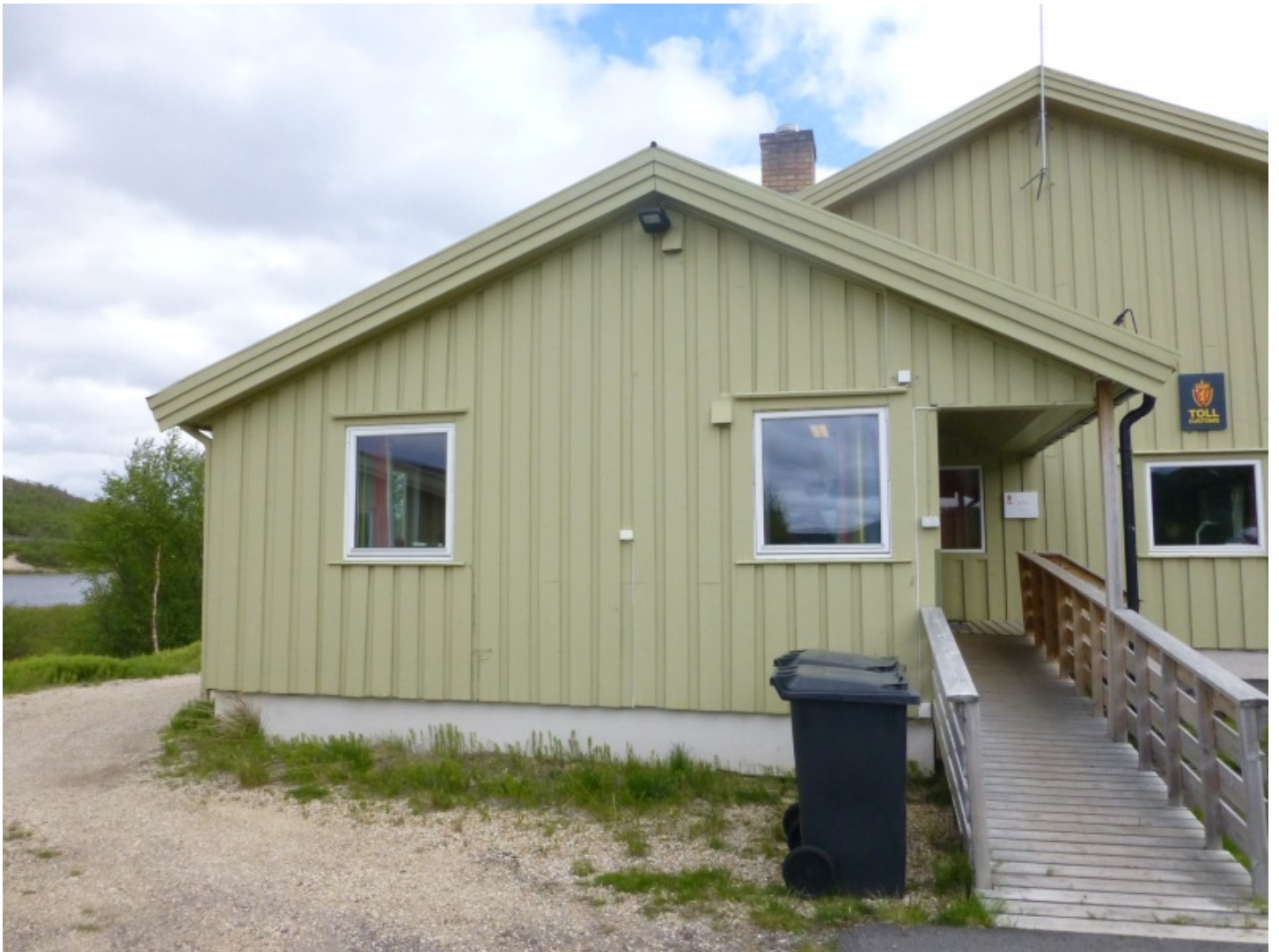
Fasade nord på tilbygget. Foto Arkitektskap juni 2016
