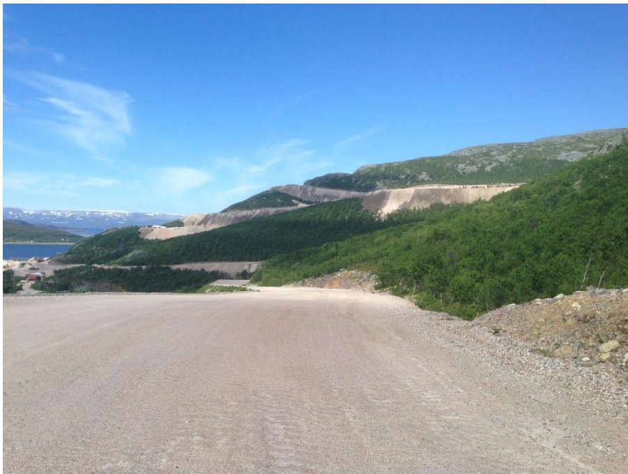
Figur 10-6. Kvarstittbruddet medfører omfattende vegfyllinger som er svært synlige mot de skogkledde hellingene. Foto: Sweco.
