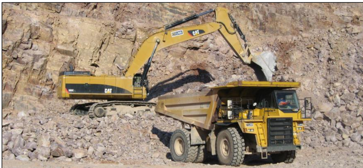
Figur 3-5. Lasting med beltegraver og transport med dumpere fra salve i dagbrudd.
