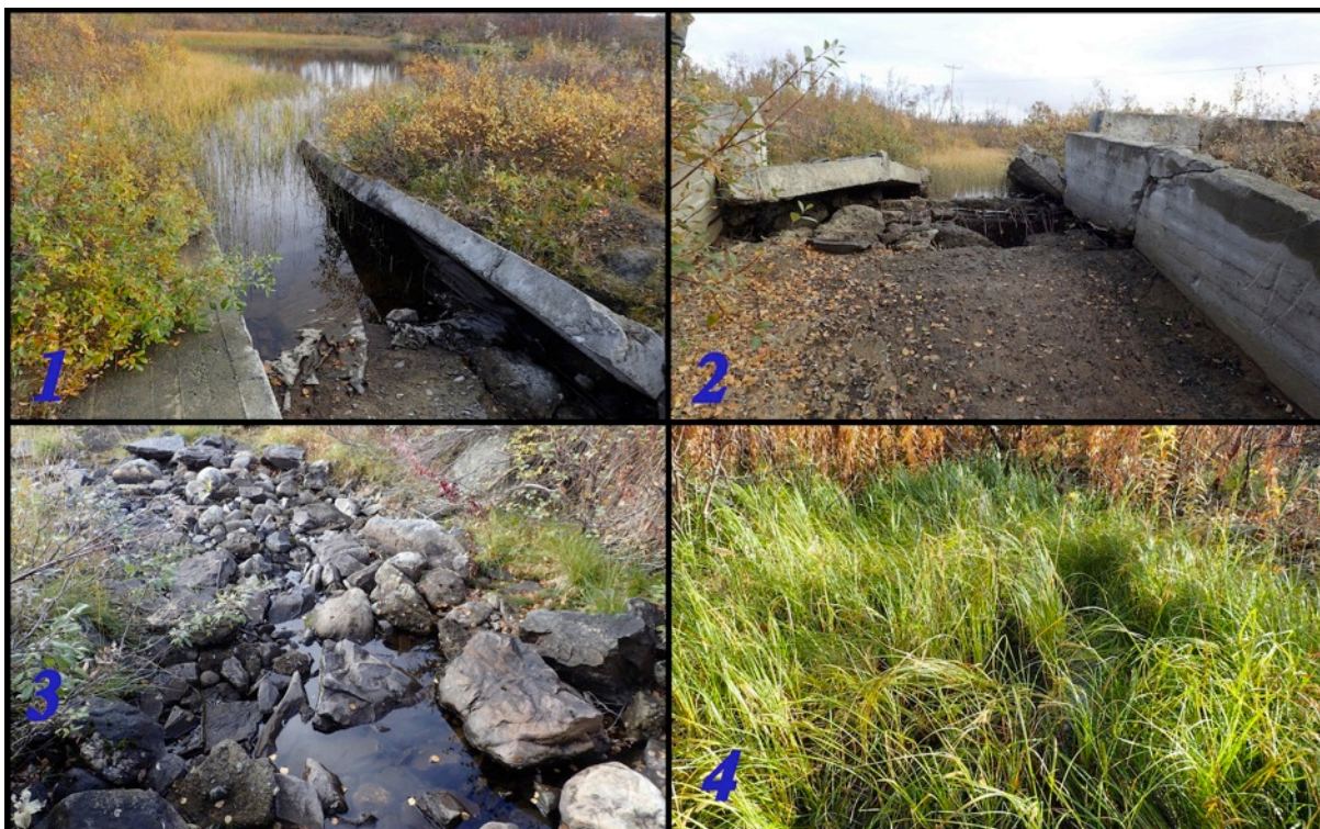
Bilde 10 Ved utløpet av øvre vannforsyningsdam er opprinnelig elveløp tørrlagt. Et oppkom finner sted et stykke nedstrøms og renner ut i opprinnelig elveleie (bilde 4).
