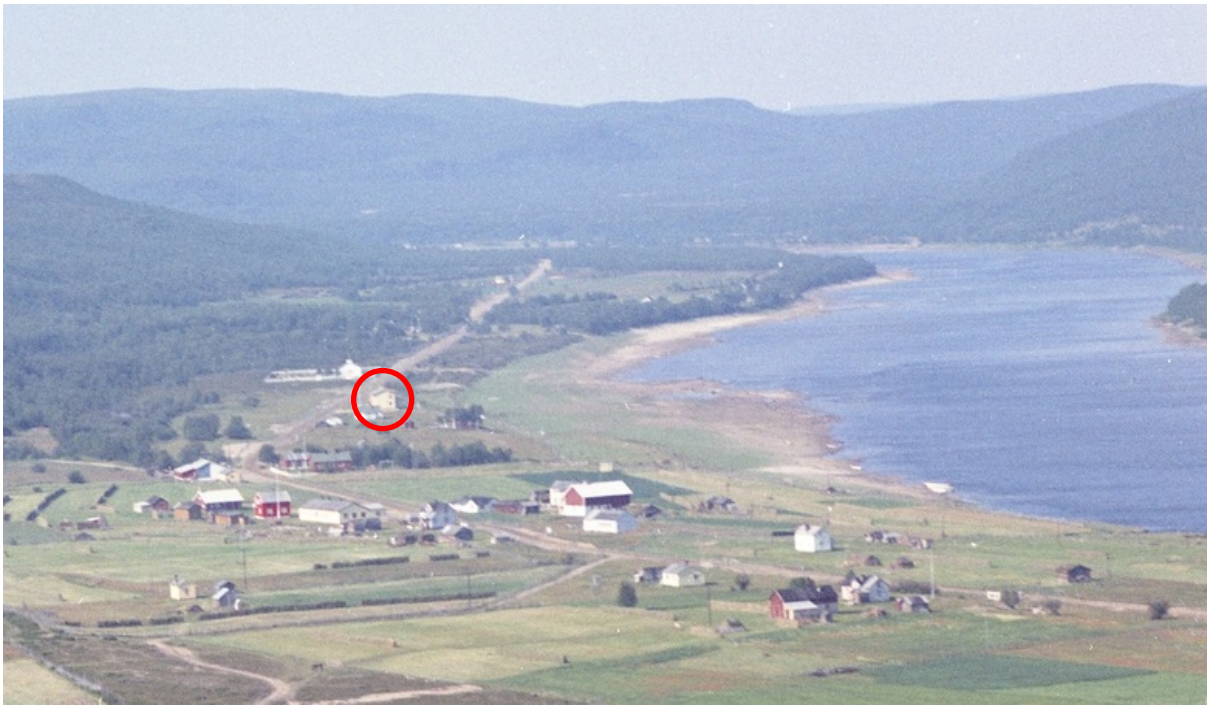
Utsnitt av flyfoto fra Fjellanger Widerøe: Polmak i 1963. Tollstasjonen (den gang lensmannskontor) sees som en større, gul bygning (markert med rød sirkel). (Tana museum/Digitalt Museum, CC BY-SA)
